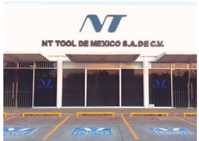
OFICINA DE MÉXICO - MEXICO OFFICE
