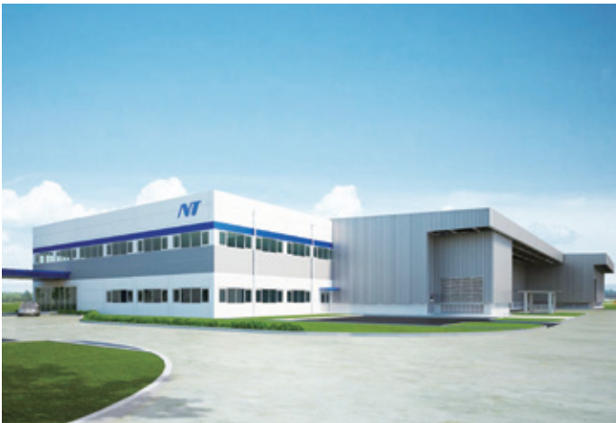
OFICINA/FÁBRICA DE INDONESIA - INDONESIA OFFICE/FACTORY
